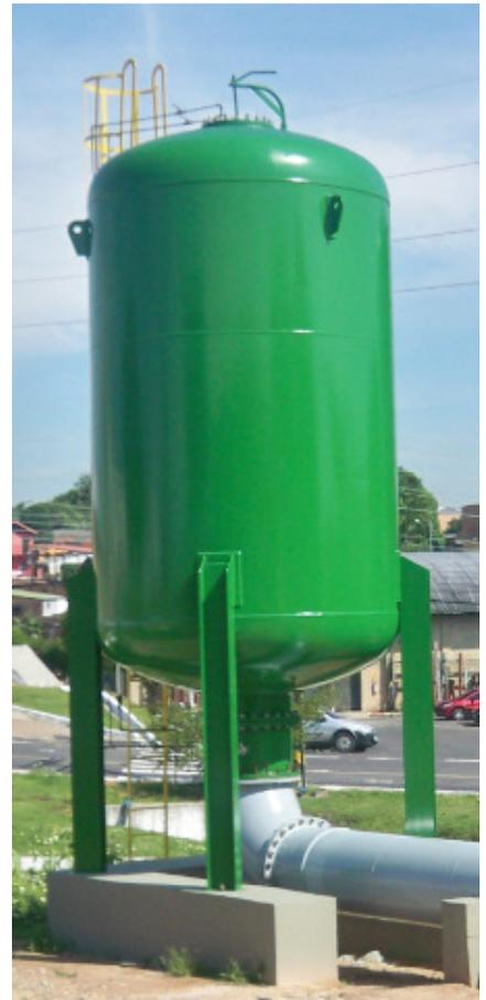
Seção III, para vasos de pressão é usado para o dimensionamento, fabricação e inspeção de todos os HYDRAMER®. Para garantia da qualidade total dos fornecimentos, todos os HYDRAMER® são submetidos a teste hidrostático de pressão conforme a norma citada ou 1,3 vezes a pressão nominal.
