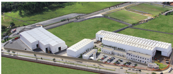
Planta de Taubaté – SP (Equipamentos) Áreas: terreno - 90.879m 2 construída – 13.002m 2
