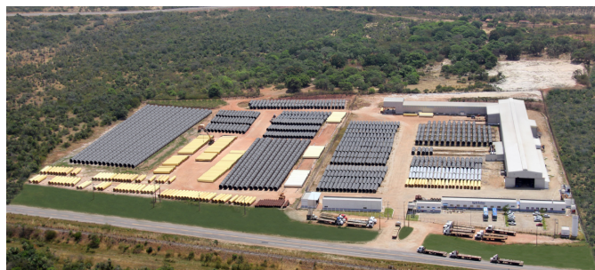
Planta de Caucaia – CE (Tubos de aço) Áreas: terreno – 320.000m 2 construída – 7.471m 2
