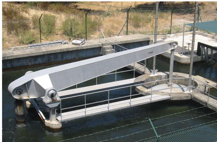
Exposto ao jato d'água, o disco se autocentra, mesmo na ausência de qualquer guia lateral. Através de uma alavanca, o disco é acionado por um flutuador cilíndrico de eixo vertical; este se desloca dentro de uma caixa comunicante com o reservatório de restituição.
