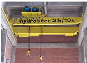
Auxilia en el montaje, operación y mantenimiento de las compuertas, válvulas y bombas.
