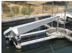
Regulación de nivel aguas abajo en la salida de la tubería bajo presión.
