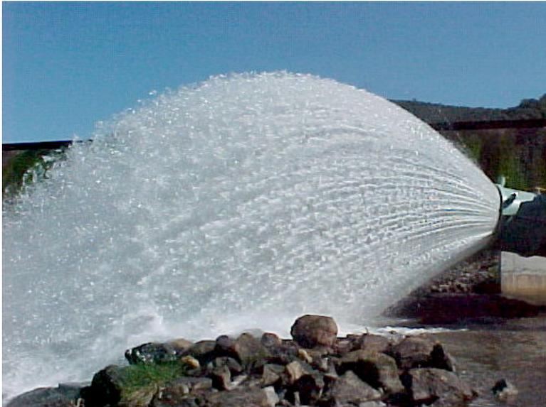
La descarga segura y regulable de grandes caudales, bajo baja o alta presión, exige un sistema de disipación importante de energía que asimismo evite la aparición de fenómenos de cavitación o vibraciones.
