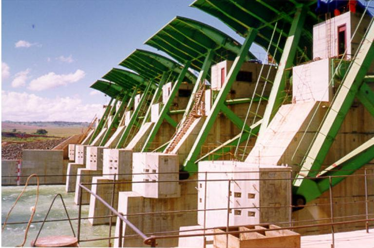
Les vannes segments ou vannes à secteur, sont normalement utilisées pour le contrôle du niveau d'eau dans un barrage ou dans un canal.
